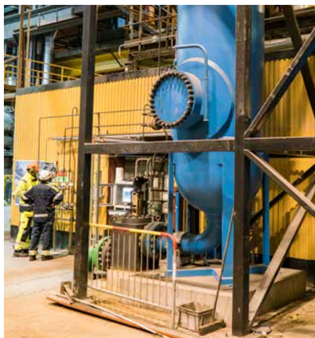
Blästartanken är 10 meter hög och har en volym på 8 kubikmeter.
