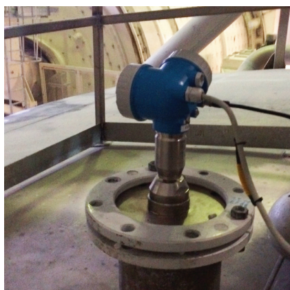
Micropilot FMR6x har installerats i befintlig studs som den tidigare 26 GHz radarn
