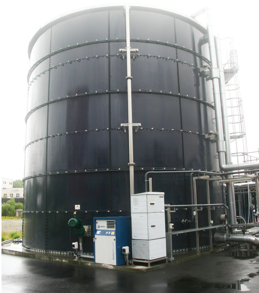
Återvinningstank på 600m 3
