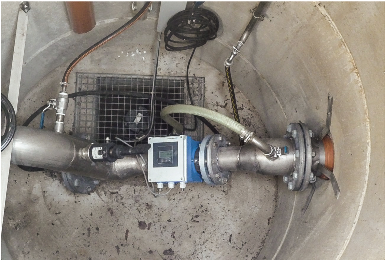
Vattenprover i ett schakt
