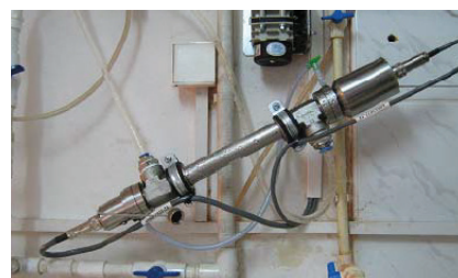
OUSAF21 färgsensor, bypass-monterad, för övergång till en dricksvattenanläggning
