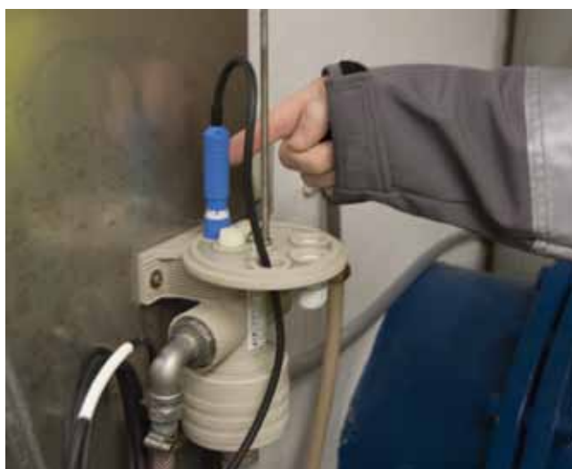
Det är enkelt att byta ut pH-elektroden som måste ersättas när elektrolytet långsamt har dränerats ut.
