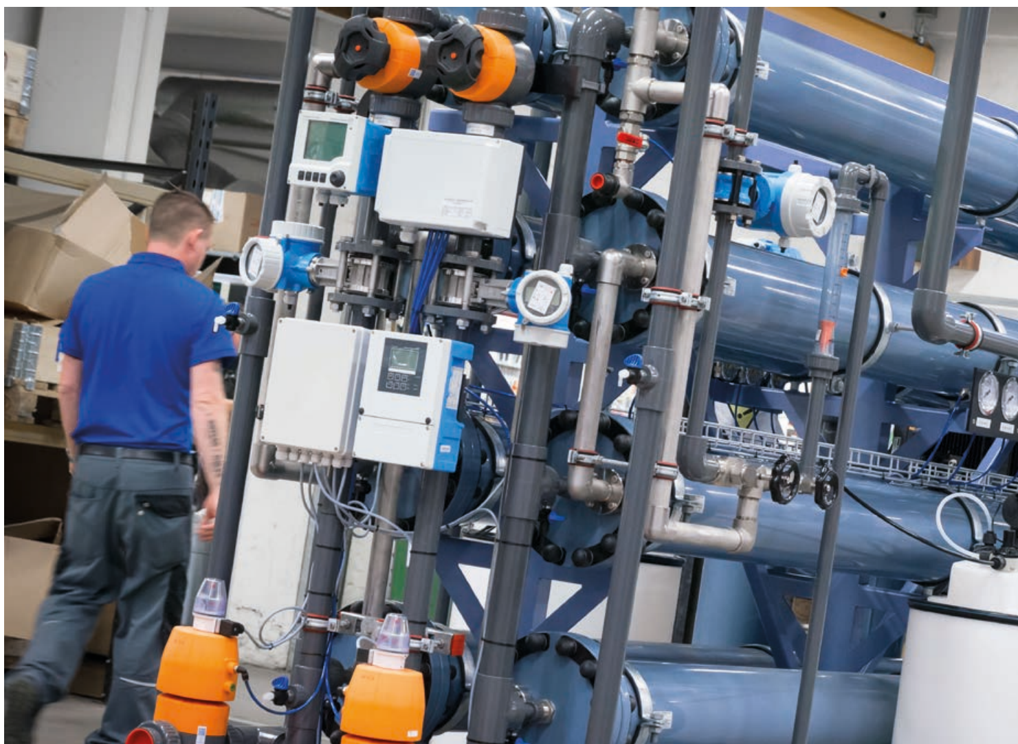
Silhorko utvecklar och producerar vattenreningsystem både till vattenverk och till industrin.
