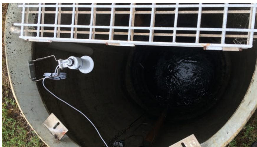
Testet av den nya radarn FMR20 genomfördes på en besvärlig applikation i en brunn med avloppsvatten från två industrier.
