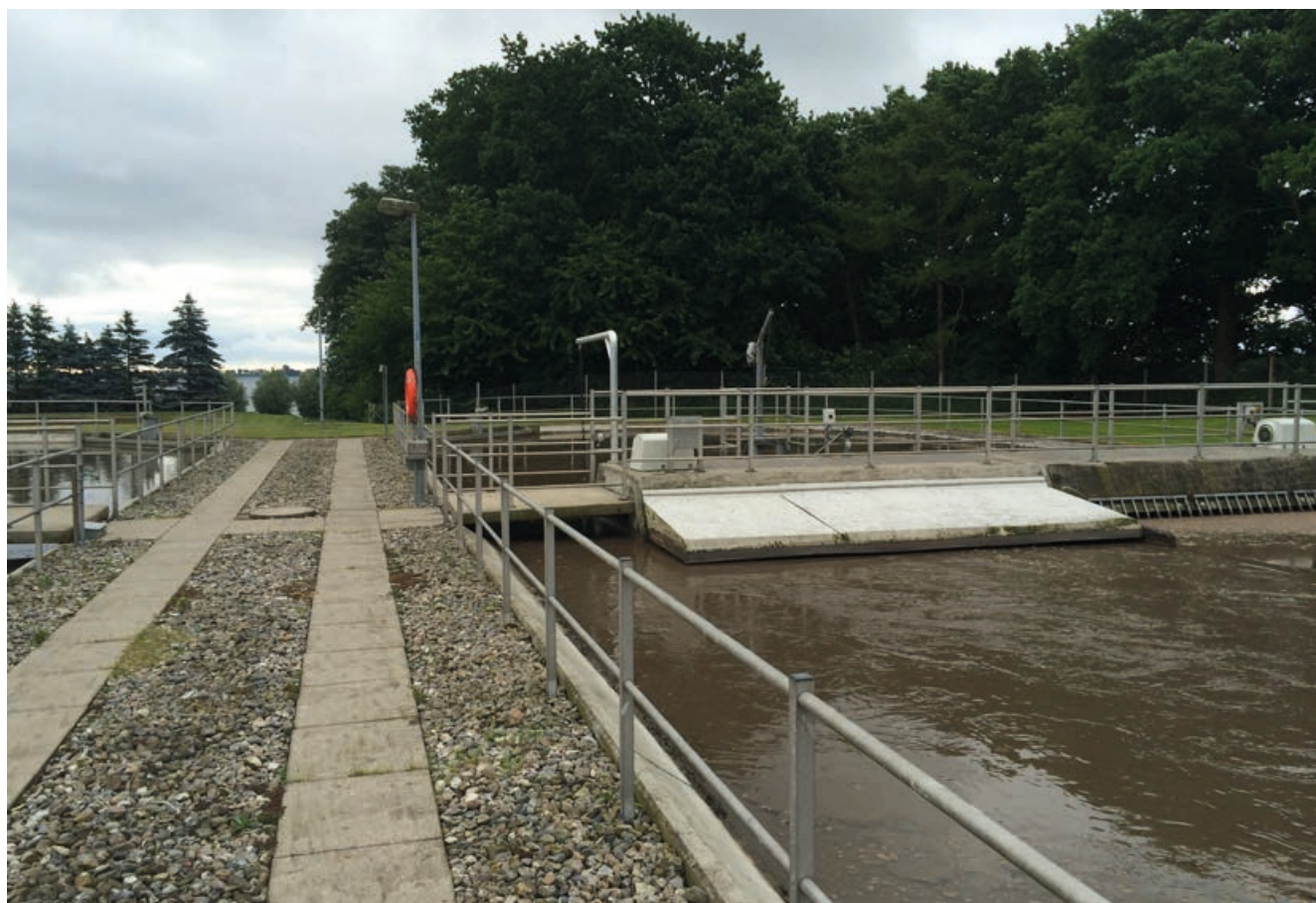
Ærø Vand omfattar tre separata reningsverk som samtliga är biogasanläggningar med slambehandling.
